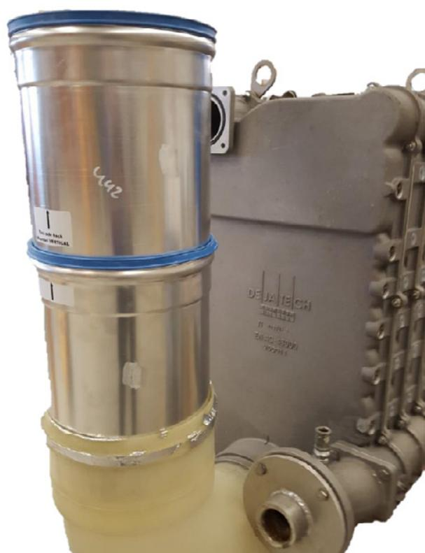
Deux silencieux montés sur une chaudière à 5 éléments (340 kW)
